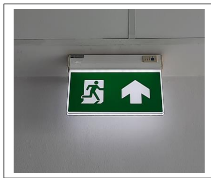
ทางหนีไฟ/บันไดหนีไฟ
